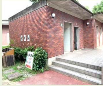
熊本市動植物園 トイレ改修視察 2019.9.21
